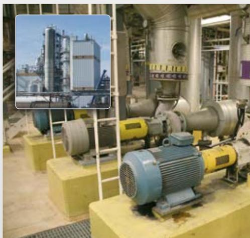
Easy-Laser®は、あらゆるプラント設備のメンテナンスや据付時に、ポンプとモーター間の芯出しに活用されています。機械設備が正確に測定、調整されて据え付けられることにより、機械寿命が長くなり、電力の省エネにも繋がります。
